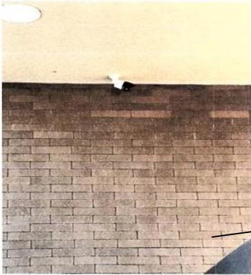
Foto 2: Cámara salida vehicular condominio (1 unidad).
